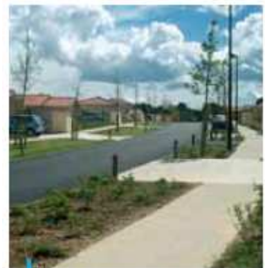
Noues engazonnées en zone pavillonnaire, Villefontaine
